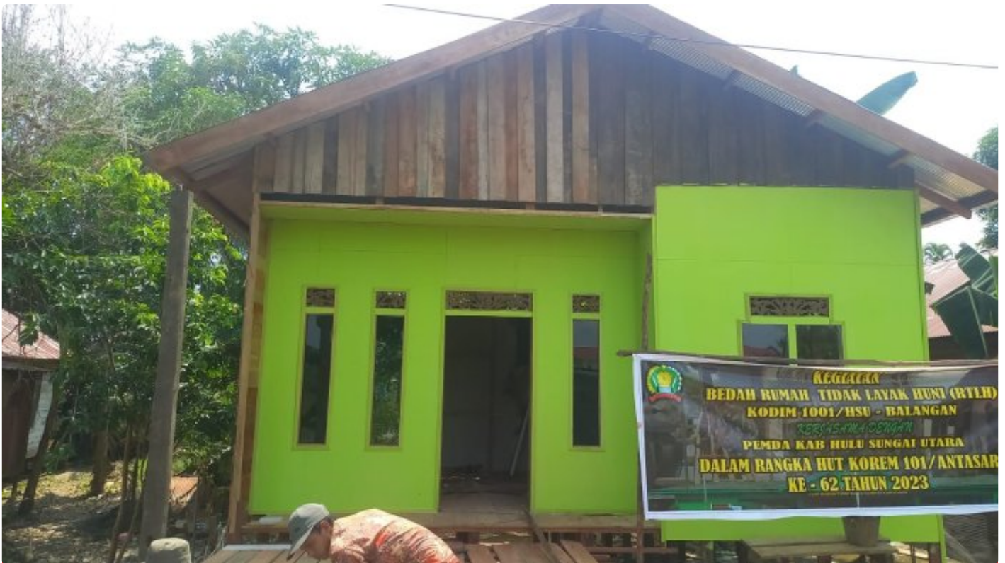
Kodim 1001/HSU-BIG Bedah Rumah Tidak Layak Huni Sambut HUT Korem 101/Antasari
